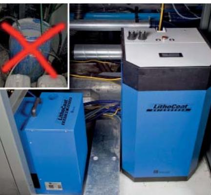
在利必达胶印机的光油供应系统中不允许有打开的容器：Harris & Bruno公司是提供在无污染的环境中进行调制、泵送和更换无迁移光油的系统的其中一家供应商
